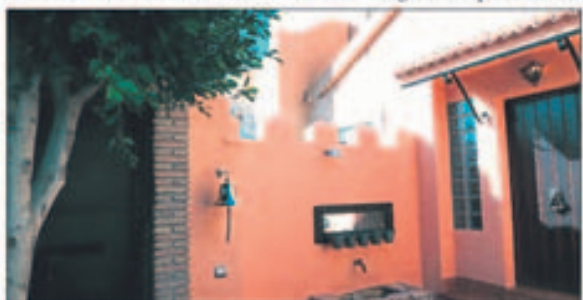
Toda la vivienda cuenta con cuidados detalles, todos en perfecto estado.
