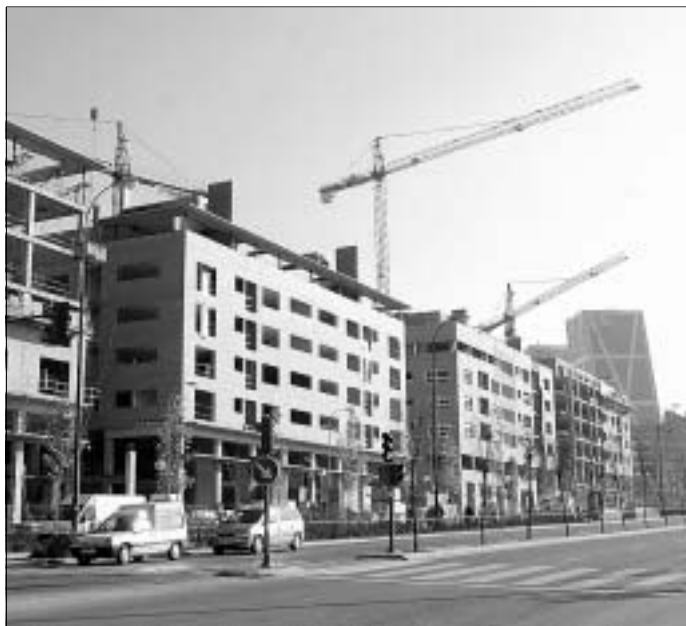
Viviendas en construcción. / Rafa Martín
