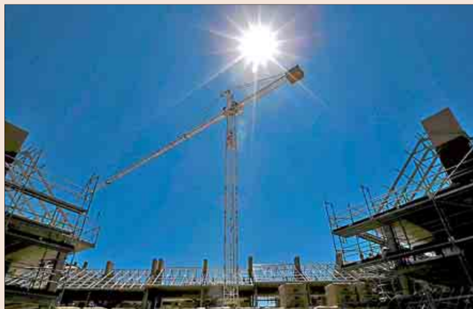
Construcción de viviendas situadas en las afueras de Madrid. / EFE
